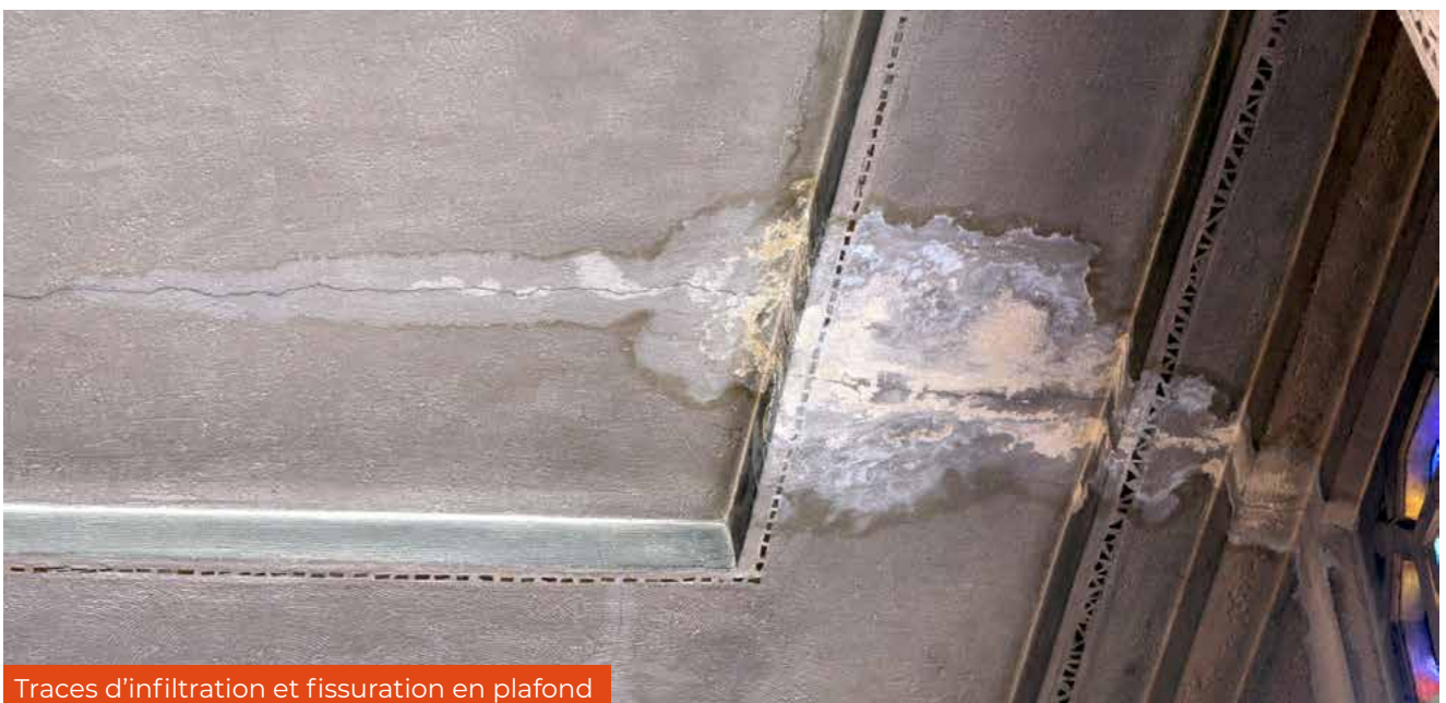
Fissure de la résille béton des vitraux
