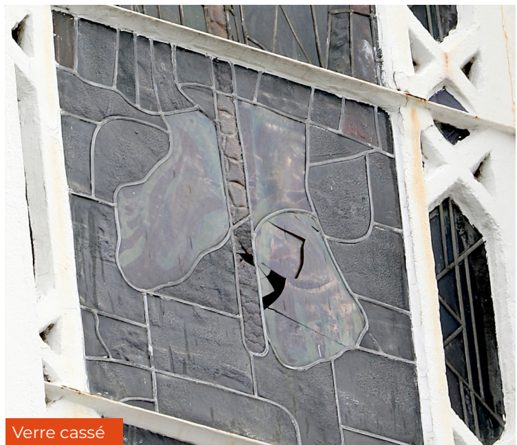
Corrosion des plombs des vitraux
