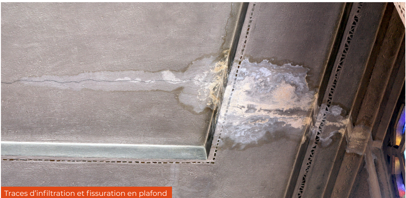
Fissure de la résille béton des vitraux
