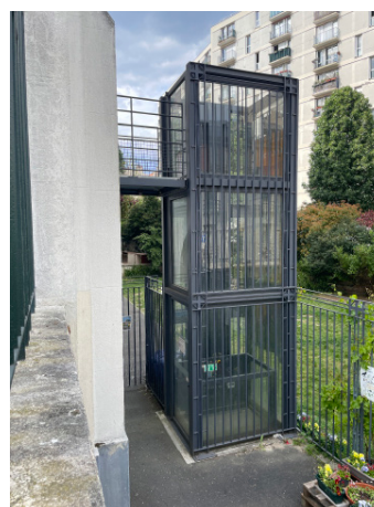
Photographie ascenseur © DSA Architecture & Patrimoine, ENSA PB, 2025
