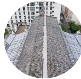
Toiture nef Tôle Fibro ciment
