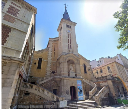
Façade principale sur la rue Source : artculturefoi.paris
