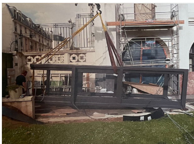
Photographie travaux de mise en accessibilité de l'église, pose d'un ascenseur extérieur et percement de la façade Est - 2015 © Paroisse St Jean Bosco
