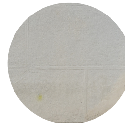
Façade Enduit "jurassite" faux appareillage
